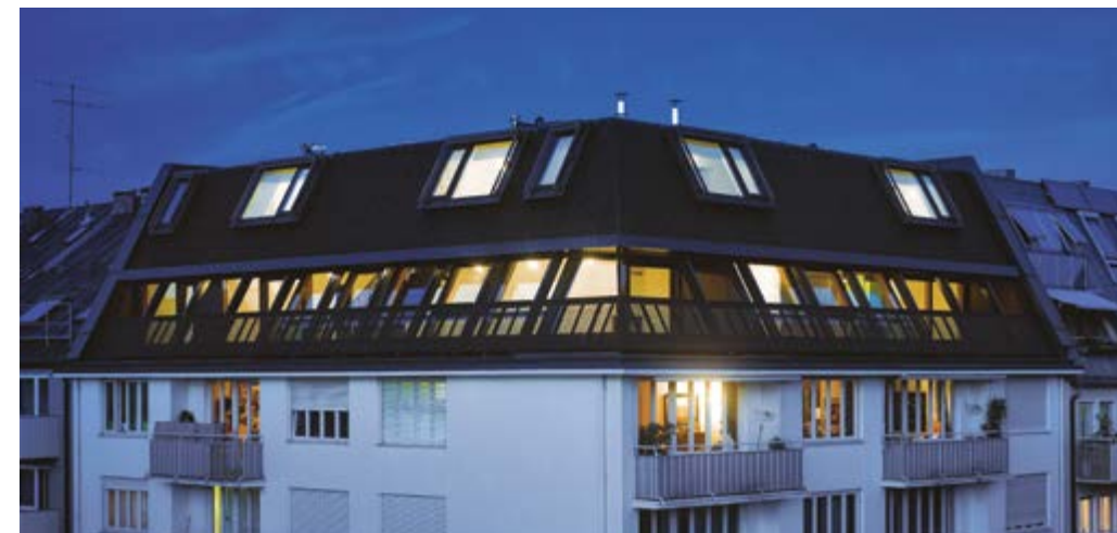
Aufstockung | Anbau | Modernisierung
